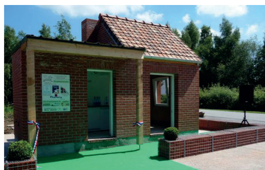
Figure 29 : Ouvrage témoin en briques cuites de sédiment
