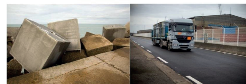
Figure 28 : Bloc d'enrochement et Route Freyssinet 12 dans le GPMD, à base de sédiments valorisés (sedilab.sediments.fr)
