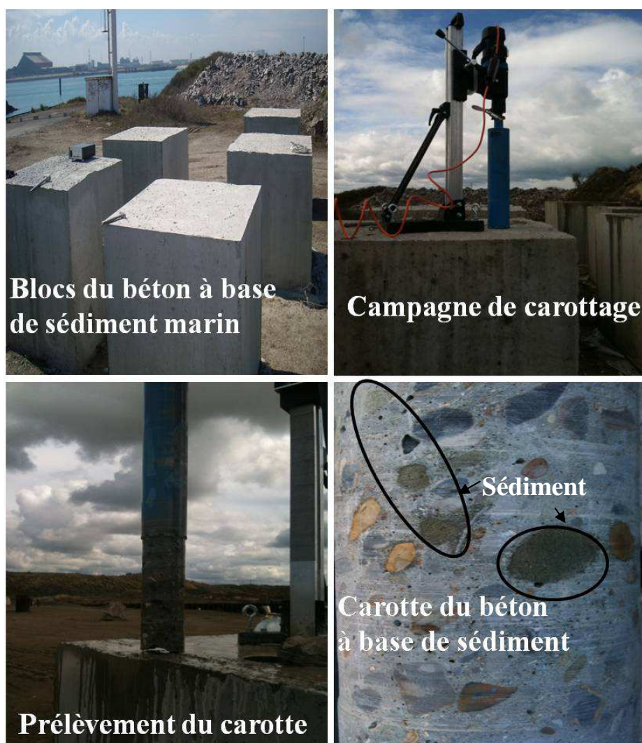
Figure 4: Campagne de carottage sur deux blocs de béton intégrant du sédiment marin [Achour, 2013]
