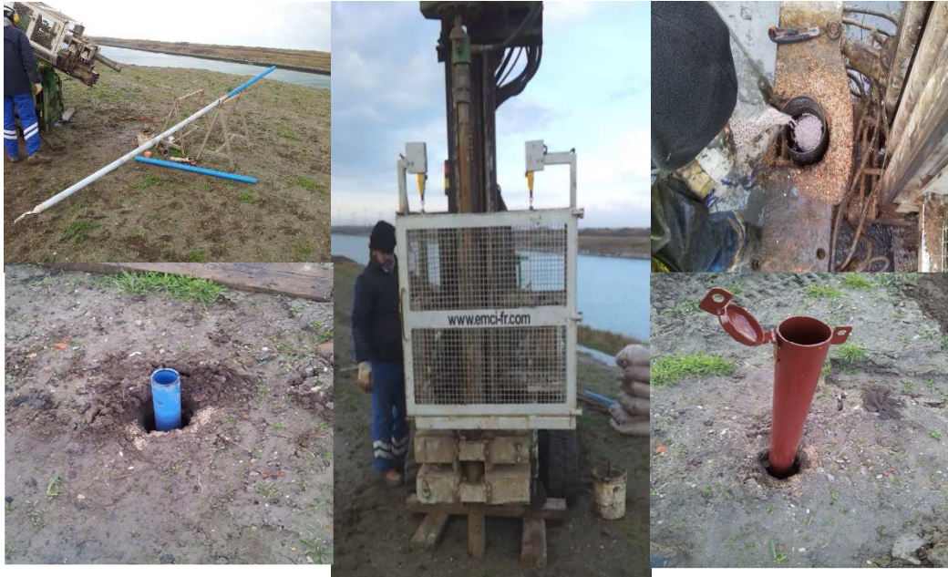
Figure 16. Installation des piézomètres
